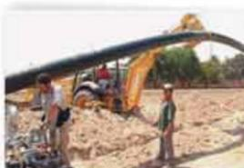
RADIO MINIMO DE FLEXION DE LA TUBERIA DE POLIETILENO
